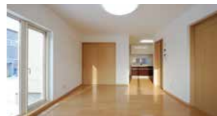
改修後の内観。掃き出し窓の手前に通気ガラリがある
