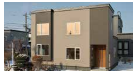
改修後の外観。断熱改修し、窓と外壁を一新
