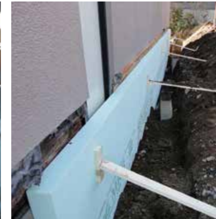
基礎外周を掘って断熱材を接着貼り
