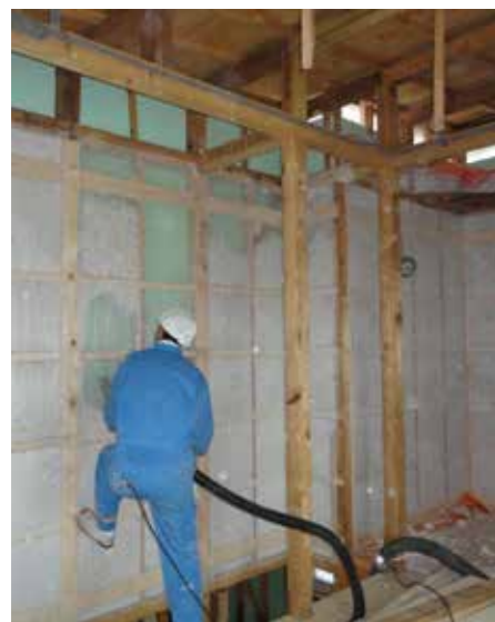
充填断熱はロックウールの吹き込みを採用
