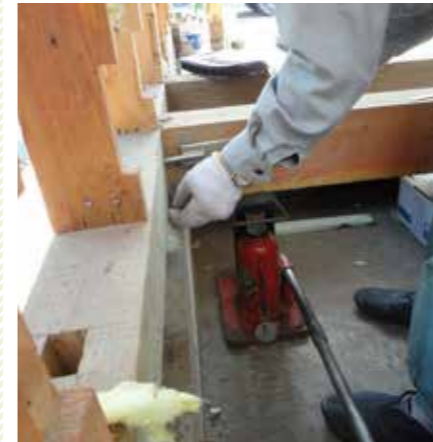
ジャッキアップしてレベルを調整する
