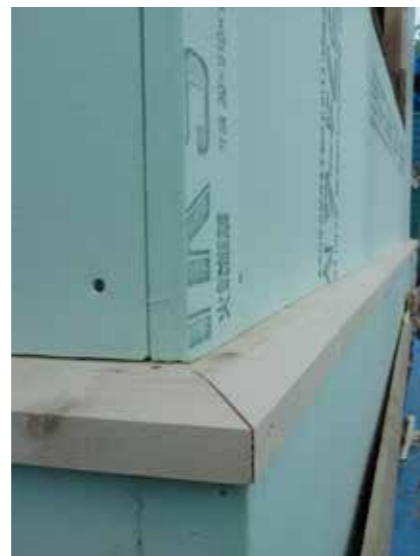
付加断熱と基礎断熱の土台水切り廻りの取り合い
