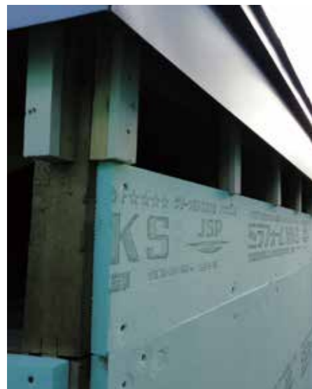
外側にポリスチレンフォームを付加断熱として設置
