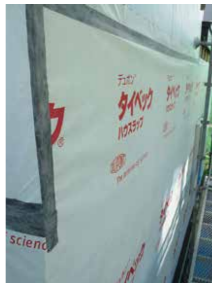
付加断熱の上から透湿防水シートを張る
