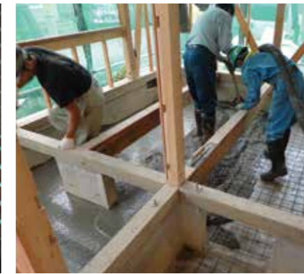
湿気防止のために防湿コンクリートを打設
