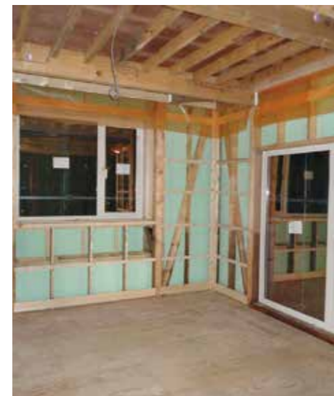
付加断熱を施しサッシが入ったところ
